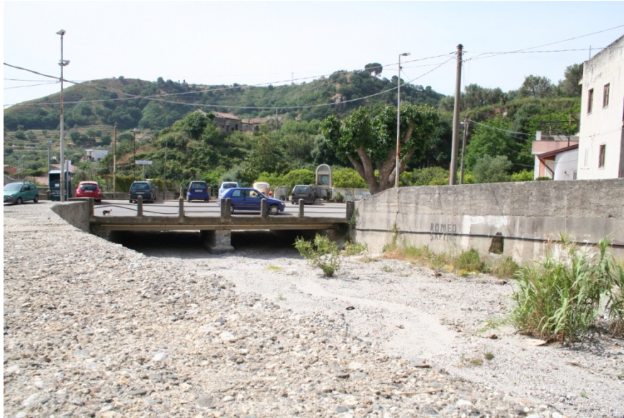
Figura 6 – Vista da monte del ponte di Galati S.Lucia
