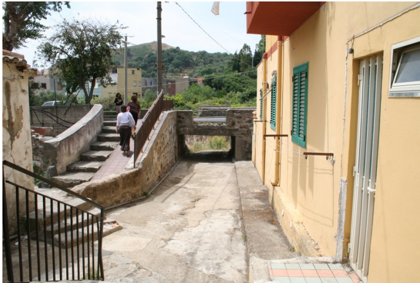
Figura 10 – Tombino scatolare a valle dell'impluvio di Figura 9
