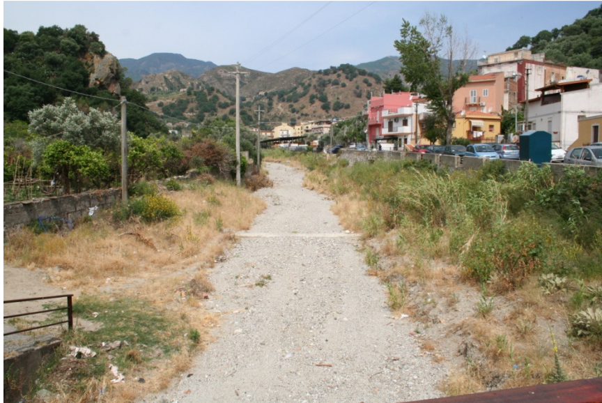
Figura 8 – Vista da valle verso monte del Torrente Galati dal ponte di Galati S. Anna
