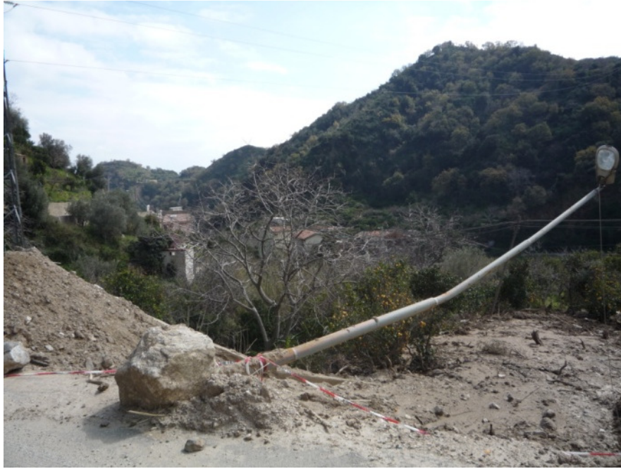
Figura 5 – Parapetto e palo della luce abbattuti da una colata che, scendendo dai versanti l'1 marzo 2011, ha attraversato la SP38.
