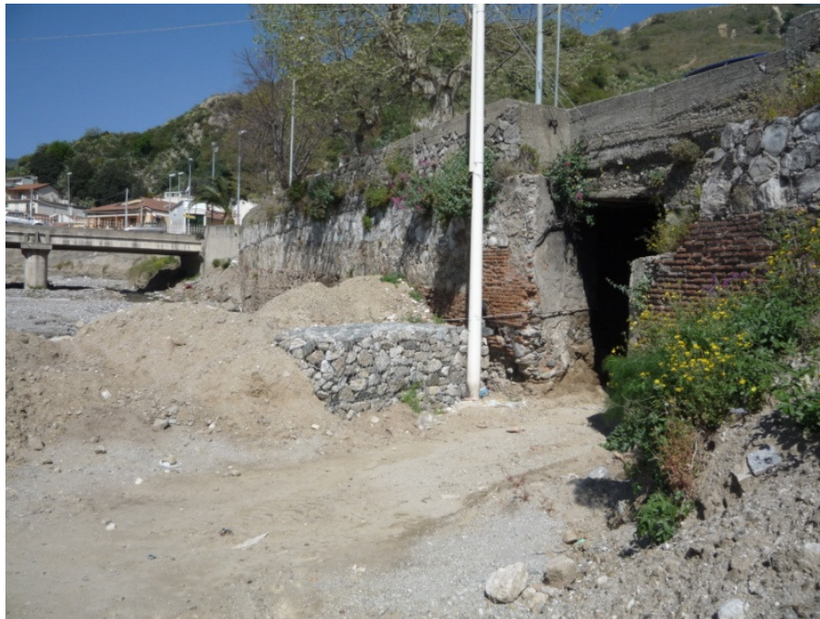
Figura 9 - Tombino che collega la piazza di Mili San Marco direttamente all'alveo del torrente, visto dall'interno dell'alveo.
