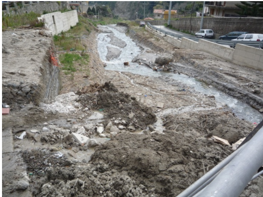
Figura 6 - Particolare del materiale presente nell'alveo del Torrente Mili, in corrispondenza dell'abitato di Mili San Pietro.
