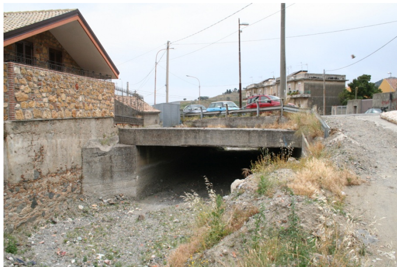
Figura 7 - Tratto con tombatura e strada di accesso al greto in località Zafferria
