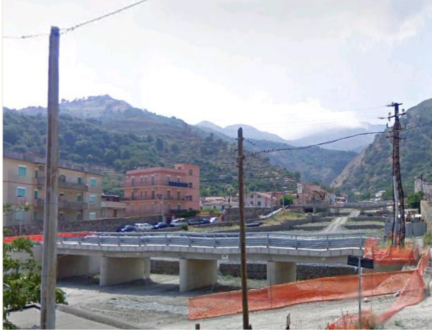
Figura 6 – Attraversamenti presenti in corrispondenza di San Filippo Superiore.
