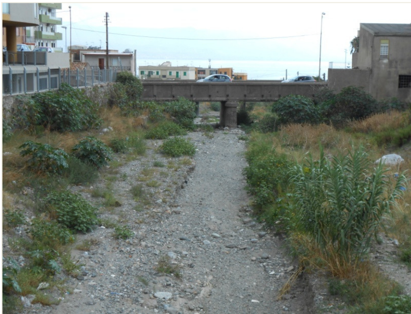
Figura 9 – Ponticello stradale presente lungo l'alveo del torrente San Filippo.
