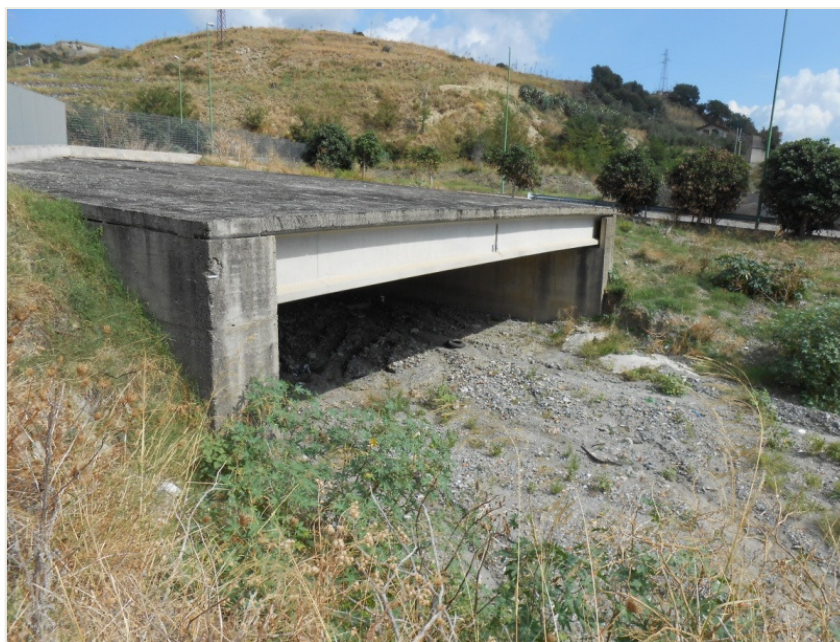
Figura 7 – Imbocco della prima copertura.
