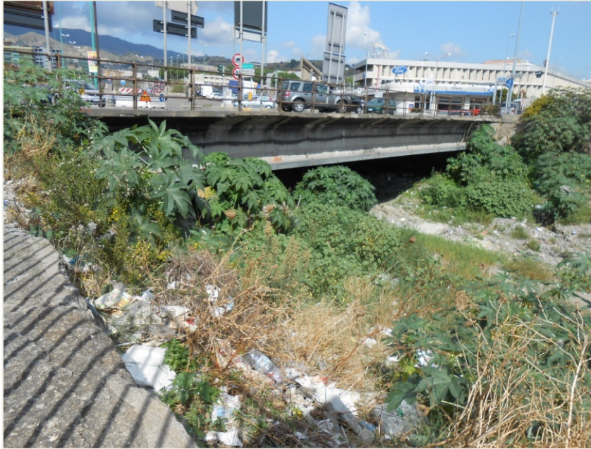
Figura 8 – Imbocco della seconda copertura.
