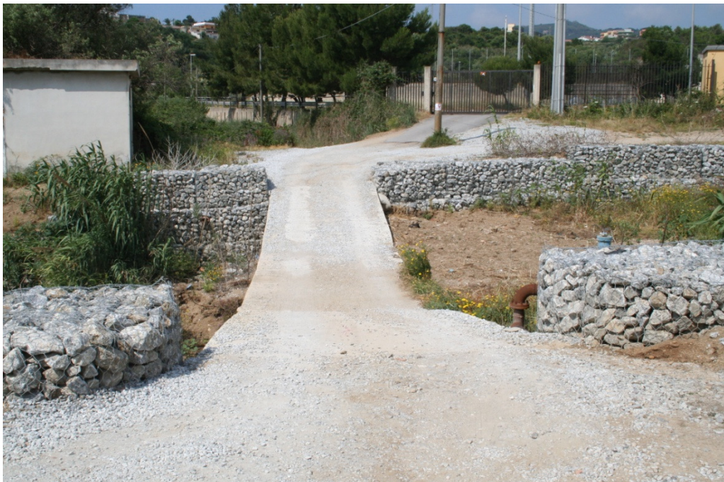
Figura 7 – Guado realizzato a monte dell'imbocco della copertura.
