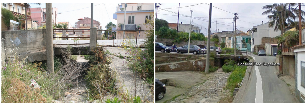
Figura 5 – Tombino presente nella località di Faro Superiore (visto da monte e da valle).
